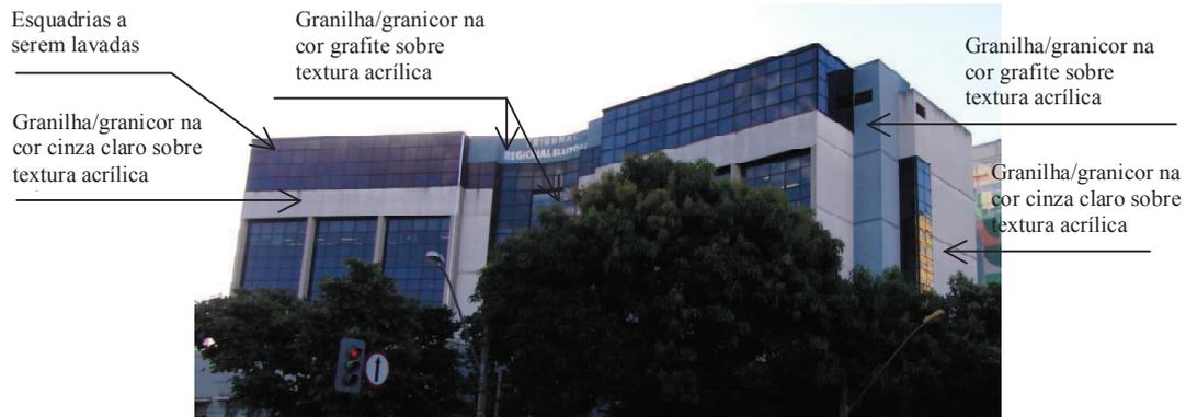
Figura 9 – Fachada frontal – Cores e revestimentos
