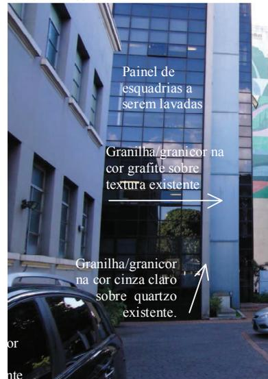
Figura 10 e 11 – Fachada frontal – Cores e revestimentos
