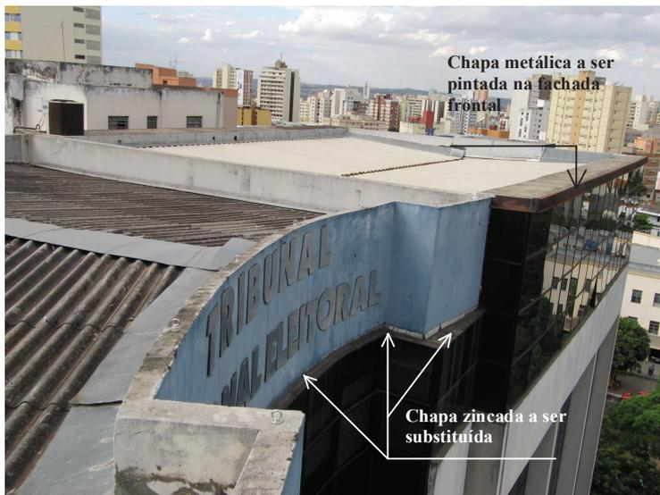
Figura 6 – Chapas metálicas a serem substituídas
