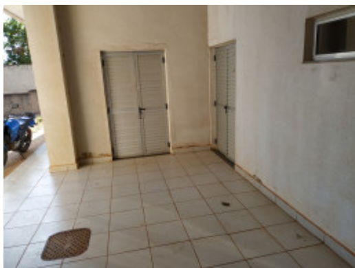
Foto 25 – Bloco I – Circulação entre blocos - Piso a ser demolido e executado novo piso em granitina e em ladrilho hidráulico pré-moldado de concreto, conforme paginação de piso na Prancha 10/11 do Projeto de Arquitetura.
