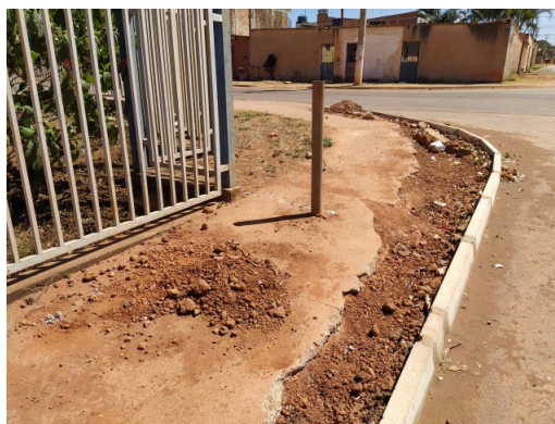
Foto 13 – Piso do passeio existente a ser demolido, executado desaterro, compactação e novo piso em concreto com espessura de 7 cm, juntas de dilatação a cada 2,00m.
