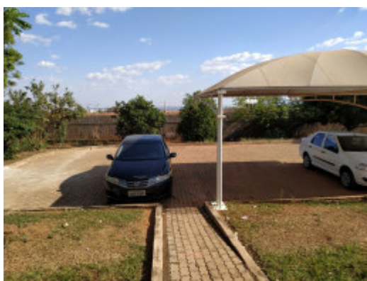
Foto 08 – Estacionamento interno – Construção de rampa de ligação entre níveis diferentes
