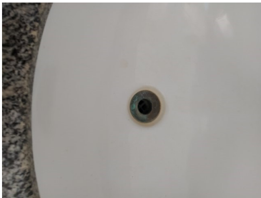
Foto 61 – Bloco II – Sanitários de uso público e de uso de servidores– Troca de válvula de lavatórios. Válvula metálica.
