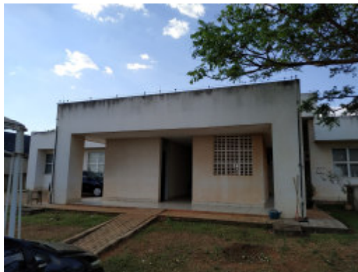
Foto 18- Bloco II – Fachada posterior – Remoção do sistema SPDA e instalação de chapim de concreto com pintura na cor concreto.
