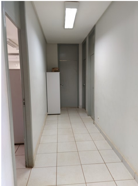
Foto 23 – Bloco I – Circulação para salas administrativas - Paredes de gesso a serem demolidas, juntamente com portas. Piso a ser demolido e executado piso em granitina. Forro de gesso a ser recortado e recomposto no entorno das paredes existentes onde serão construídas novas paredes
