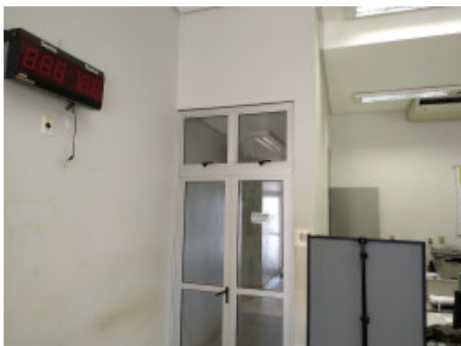
Foto 44 – Bloco I – Atendimento - Remoção de porta existente e instalação de porta em vidro temperado com uma folha móvel. Execução de pintura interna com tinta acrílica na cor branco gelo.
