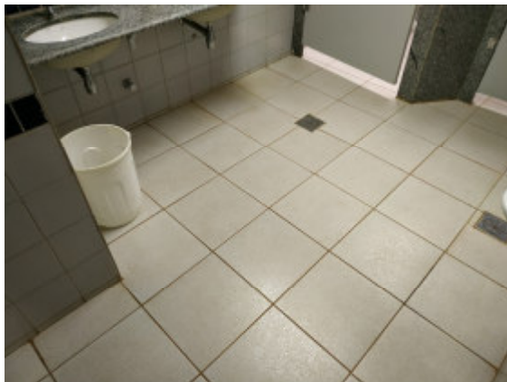
Foto 48 – Bloco I – Sanitário de uso público - iso, divisórias, revestimento, portas, mictórios, espelhos, porta principal, bacia sanitária do gabinete acessível a serem demolidos. Reconstrução de todos os revestimentos e acabamentos do sanitário. Bancada com lavatórios a ser removida e reinstalada em altura indicada em projeto, Prancha 08/11. Sifões a serem substituídos, torneiras a serem substituídas por peças com acionamento tipo alavanca, tampas das caixas e ralos a serem trocadas.
