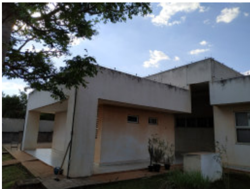
Foto 17- Bloco II – Fachada lateral – Remoção do sistema SPDA e instalação de chapim de concreto a ser rejuntado e pintado na cor concreto.
