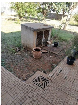
Foto 69 – Casa de gás – Aplicação de textura acrílica nas paredes externas, pintura acrílica nas paredes internas na cor branco gelo, aplicação de manta líquida na superfície da marquise, pintura de portinholas com esmalte sintético, cor platina. Ladrilho hidráulico das calçadas a serem lavados e substituídas as peças quebradas.
