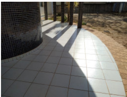
Foto 19 – Bloco I – Acesso ao prédio/ Área da marquise circular - Demolição de piso e execução de piso em granitina. Remoção do rodapé na parede curva e execução de rodapé em granitina.
