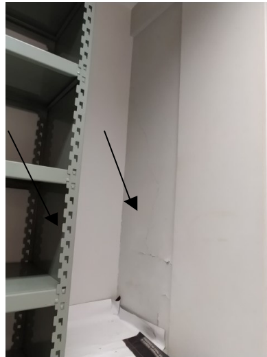
Foto 56 – Remoção de revestimento danificado no canto de parede do depósito de urnas. Remoção de todo o revestimento com descolamento e com sinais de umidade, aplicação de Sikatop 100 e posterior emassamento e pintura acrílicos.
