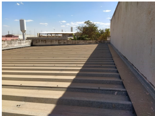
Foto 67 – Bloco I – Ala lateral - Telhado a receber placa de EPS pantografado, instalação de telha galvalume, instalação de novos rufos, aplicação de textura acrílica na cor branco gelo na face interna das platibandas, instalação de chapim pré-moldado de concreto com rejunte e pintura dos mesmos.
