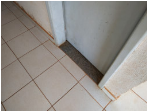
Foto 65 – Bloco II – Piso a ser demolido e construído, piso em granitina. Portas a serem demolidas e construídas portas e portais metálicos, substituída soleira em granito, aplicada textura acrílica nas paredes.
