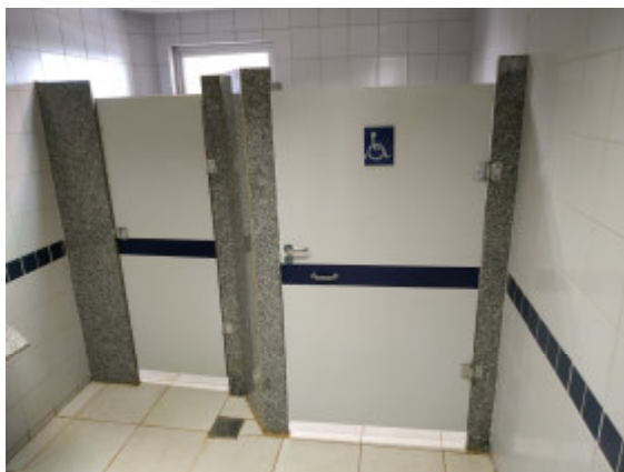
Foto 50 – Bloco I – Sanitários de uso público – Revestimentos – piso e parede – serão demolidos com seleção de peças do revestimento para assentamento nas áreas do Bloco II em que serão fechadas as bandeiras. Pintura de teto com tinta látex PVA na cor branco neve sobre laje.
