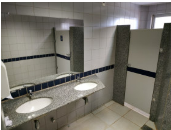
Foto 49 – Bloco I – Sanitários de uso público – Revestimentos a serem demolidos, divisórias, portas, sifões e torneiras (com reinstalação das torneiras nos sanitários do Bloco II e lavabo). Bancada deverá ter altura de instalação alterada para 80cm. Válvulas dos lavatórios deverão ser trocadas.
