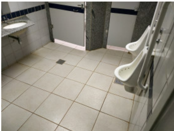
Foto 47 – Bloco I – Sanitário de uso público - Piso, divisórias, revestimento, portas, mictórios, espelhos, porta principal, bacia sanitária do gabinete acessível a serem demolidos. Reconstrução de todos os revestimentos e acabamentos do sanitário: portas em alumínio, piso em porcelanato, divisórias em granito, espelhos cristal com 4mm. Baras ao lado dos mictórios serão removidas e reinstaladas nos gabinetes acessíveis.
