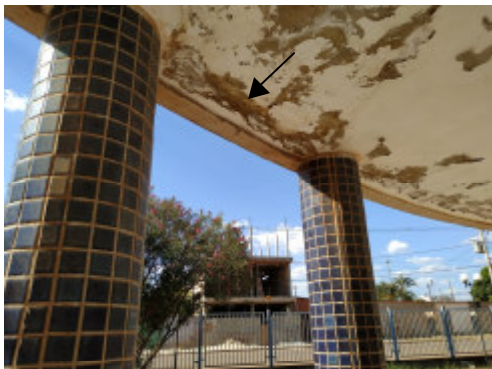
Foto 35 – Bloco I – Laje de forro da marquise circular – Remoção de reboco e recomposição, conforme indicação de planta de forro, após aplicação de cimento cristalizante. Remoção de acabamento, novo emassamento e pintura acrílicos em toda a laje.
