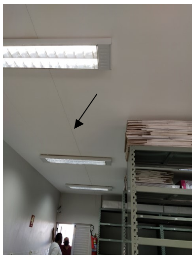
Foto 53 – Bloco I – Galpão de urnas – Trinca na laje e na parede do depósito a serem abertas, aplicado PU, fita telada de poliéster para posterior emassamento e pintura.
