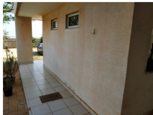
Foto 26 – Bloco II – Circulação lateral - Piso a ser demolido e construído piso em ladrilho hidráulico, juntamente com rodapé. Remoção de textura na base das paredes, aplicação de sikatop 100, e reaplicação de textura na cor cinza inox, cód. C388.
