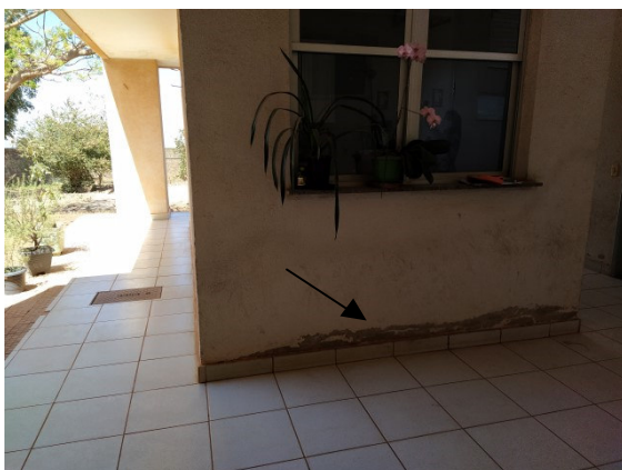
Foto 39 – Bloco II – Remoção da textura na base das paredes até a altura de 70 cm, aplicação de Sikatop 100 e aplicação de textura acrílica na cor cinza inox, Suvinil ou equivalente, Cód. 388.
