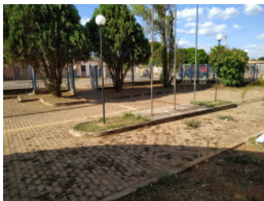
Foto 07 – Atual acesso de pedestres a ser demolido – Árvores de pequeno porte a serem removidas.
