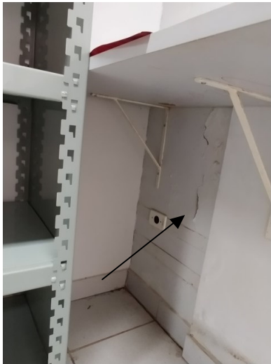
Foto 55 – Remoção de revestimento danificado no canto de parede do depósito de urnas. Remoção de todo o revestimento com descolamento e com sinais de umidade, aplicação de Sikatop 100, em 3 demãos, e posterior emassamento e pintura acrílicos.
