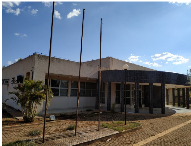
Foto 01 – Fachada frontal – Cartório Eleitoral de Valparaíso _ Limpeza de pastilhas com água esabão neutro, aplicação de textura acrílica nas fachadas conforme indicação de projeto – Prancha 06/11 de arquitetura. Aplicação de manta líquida no topo da platibanda circular.
