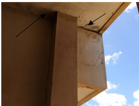
Foto 37 – Blocos I – Circulação - Tratamento de pontos de umidade com recomposição de reboco, aplicação de cimento cristalizante, reboco com argamassa contendo aditivo impermeabilizante, emassamento e pintura acrílicos.
