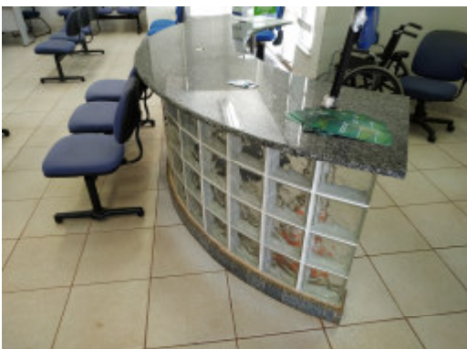
Foto 43 – Bloco I - Atendimento - Balcão em tijolo de vidro a ser demolido e construído novo balcão em alvenaria no local indicado em projeto. Na parede curva deve ser instalado rodamão de 20 cm, na altura de 80 cm.
