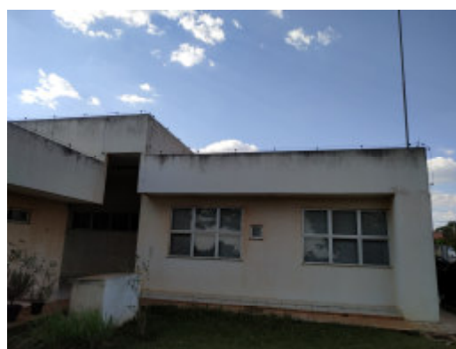
Foto 16 – Bloco I – Fachada posterior - Sistema SPDA a ser removido. Instalação de chapim de concreto em todas as platibandas. Aplicação de textura acrílica em todas as paredes externas.
