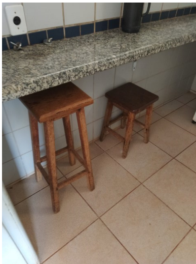
Foto 57 – Bloco II – Copa – Piso a ser demolido e executado novo piso em porcelanato, dimensões de 60x60 cm. Revestimento de parede a ser mantido e todas as tomadas a serem substituídas.
