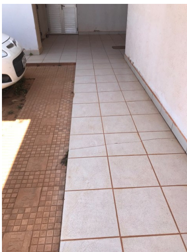
Foto 27 – Bloco II – Circulação lateral - Piso cerâmico a demolir e a ser executado novo piso em ladrilho hidráulico, juntamente com rodapé, conforme paginação contida na Prancha 10/11 de arquitetura. O piso em ladrilho existente deverá ser lavado com jato d'água e sabão neutro, além de substituídas as peças quebradas.
