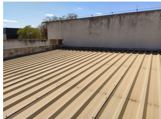
Foto 68 – Bloco I – Ala lateral - Telhado a receber placa de EPS pantografado e telha galvalume sobre o mesmo, instalação de novos rufos, aplicação de textura acrílica na cor branco gelo na face interna das platibandas, instalação de chapim pré-moldado de concreto com rejunte e pintura dos mesmos.
