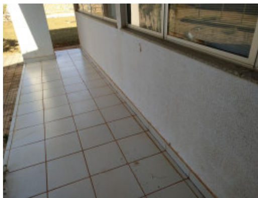
Foto 20 – Bloco I – Marquises laterais - Demolição de piso e rodapé existentes e execução de piso e rodapé em granitina.
