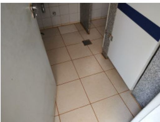
Foto 63– Bloco II – Sanitários de uso de servidores – Troca de piso, troca de porta principal de acesso com vedação de bandeira em alvenaria e execução de verga, troca de portas de acesso à gabinetes sanitários por portas de alumínio.
