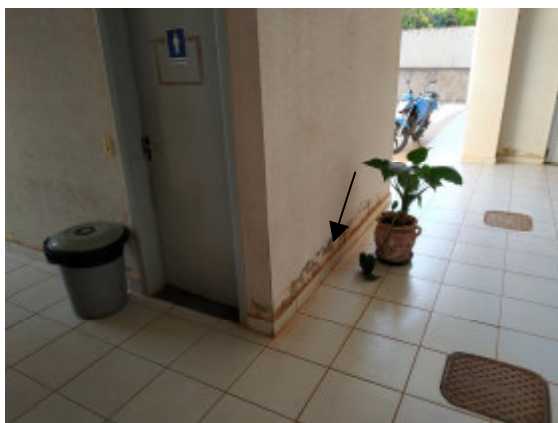
Foto 40 – Bloco II – Remoção da textura na base das paredes até a altura de 70 cm, aplicação de Sikatop 100 e de textura acrílica na cor cinza inox, Suvinil ou equivalente, Cód. 388.
