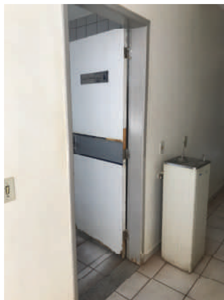
Foto 41 – Portas de madeira Bloco II e piso a serem demolidos e reconstruídos – Piso em granitina e portas metálicas
