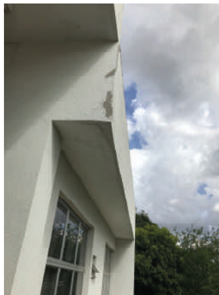
Foto 39 – Marquises/ Beiral das áreas laterais do Bloco I – Recomposição de textura na cor branco gelo, emassamento e pintura acrílicos no teto
