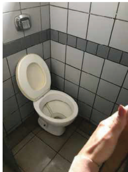
Foto 47 – Serviço Bloco II – Demolição de piso, revestimento, divisórias, louças e portas de madeira para instalação /assentamentos de novos acabamentos
