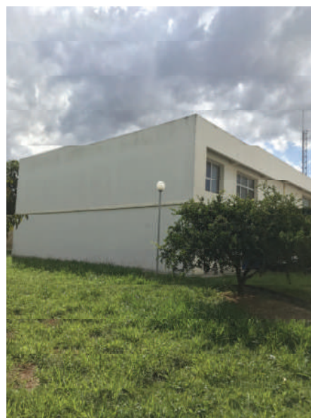
Foto 15 – Fachada lateral do bloco III – Aplicação de textura nas fachadas em geral, após remoção das partes com esfarelamento e aplicação de fundo preparador
