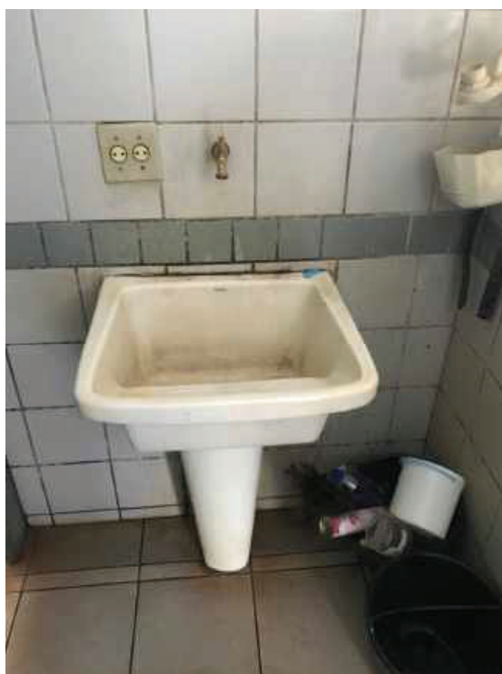
Foto 48 –Serviço Bloco II – Troca revestimentos, tanque e instalação de novo sifão
