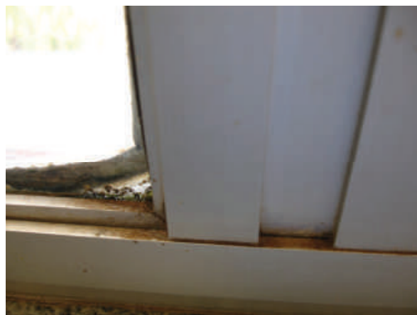
Foto 37- Limpeza de esquadrias com água, sabão neutro e pano macio. Troca de borrachas EPDM
