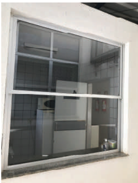
Foto 40 – Janela e peitoril/ bancada a serem demolidos para instalação de nova esquadria em vidro temperado de correr e instalação de grade na face interna
