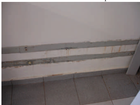
Foto 36 – Remoção de eletrocalhas de parede para execução de instalações embutidas
