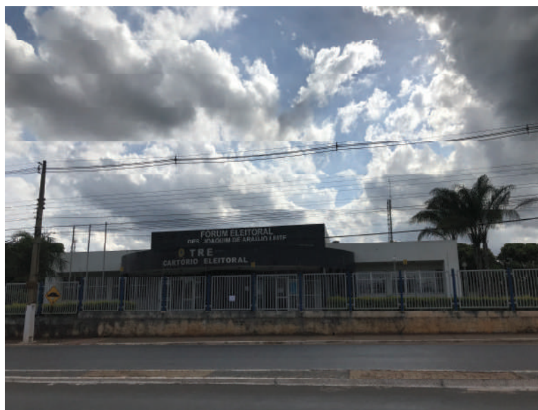
Foto 2 – Vista geral do prédio – Fachada frontal – Avenida Sarah Kubitschek
