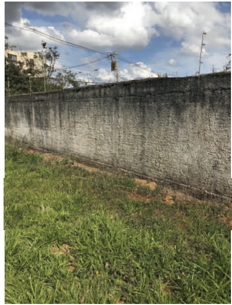
Foto 17 – Muro a receber chapim pré-moldado de concreto e pintura acrílica, na cor branco gelo
