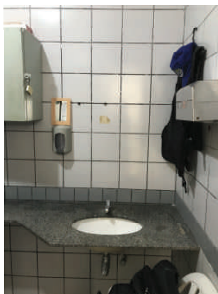
Foto 45 – Banheiros de servidores Bloco II – Demolição de pisos, revestimentos e divisórias com instalação/assentamento de novos acabamentos; instalação de espelho e novos acessórios; bancada com lavatório a ser mantida e instalado rodamão
