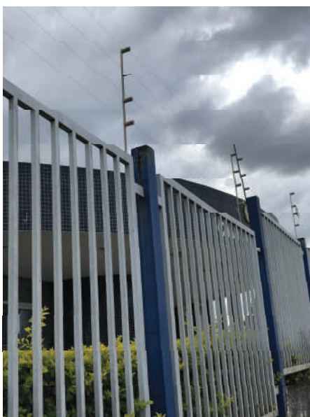
Foto 10 – Gradil a receber nova pintura com recuperação de alguns postes
