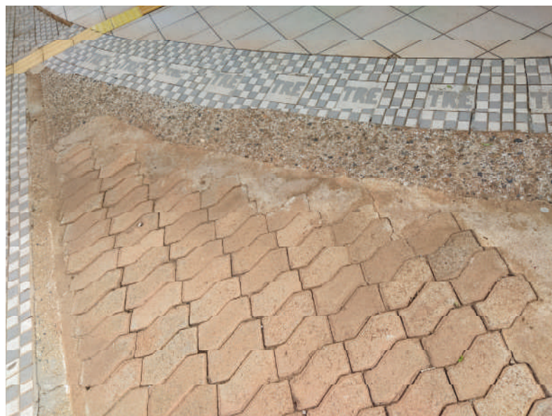
Foto 7 – Calçada no contorno da marquise circular, a ser demolida e reconstruída, com suave inclinação até o nível do piso da marquise e piso a em blocos intertravados
