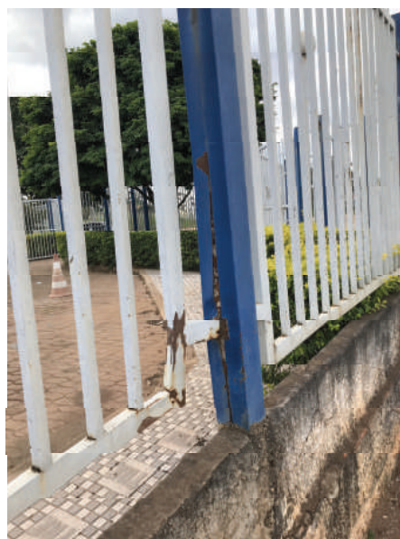
Foto 11 – Partes do gradil a serem recuperadas – Substituição dos postes por novas peças, concretagem do interior, chumbamento, solda aos painéis laterais e nova pintura na cor cinza platina
