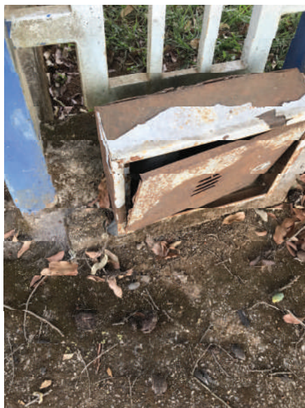
Foto 12- Substituição da caixa do hidrômetro
