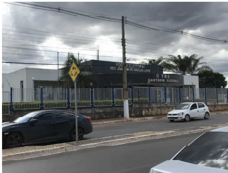
Foto 1 – Visão geral do prédio a ser reformado
