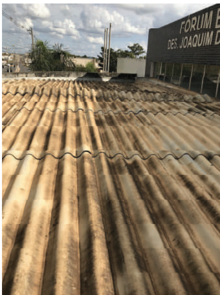
Foto 18 – Telhado da marquise circular a ser reconstruído (incluindo calhas e rufos), janela a ser demolida e vão vedado com alvenaria de blocos cerâmicos
