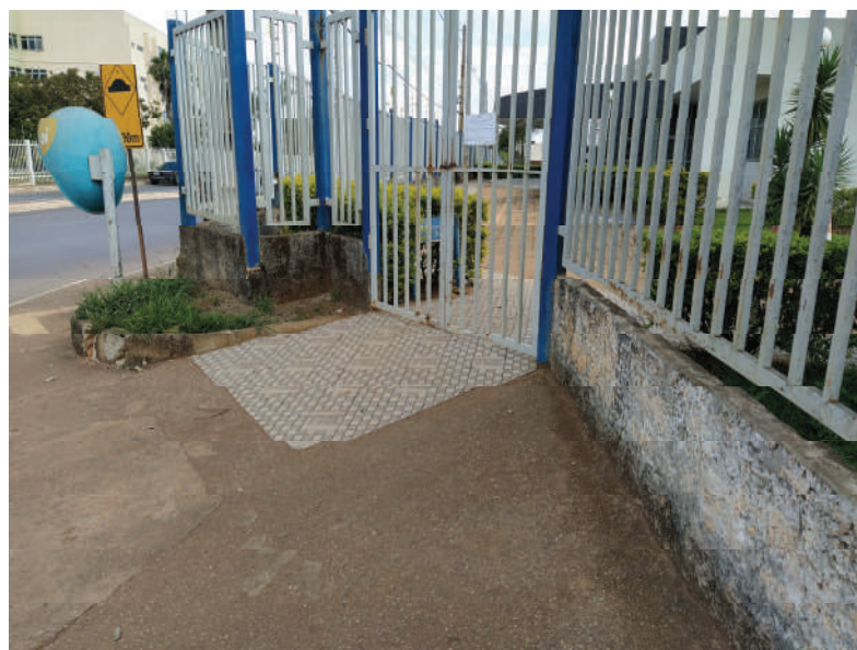
Foto 3 – Acesso de pedestres – Vista externa – Acesso a ser readequado
