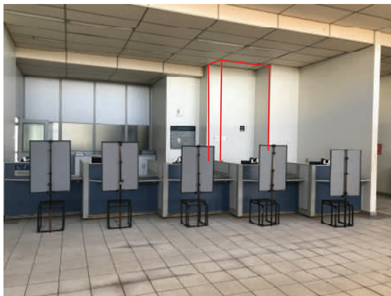
Foto 26 – Atendimento Bloco I – Piso e forro a serem demolidos, paredes a serem demolidas e construídas para adaptações nos banheiros de uso público
