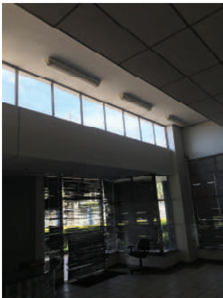
Foto 24 – Bloco I – Área de atendimento - Remoção de esquadria, vedação do vão, demolição de balcão em tijolo de vidro, instalação de grades nos vãos das esquadrias
