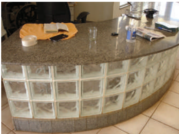
Foto 27 – Balcão em tijolo de vidro a ser demolido
