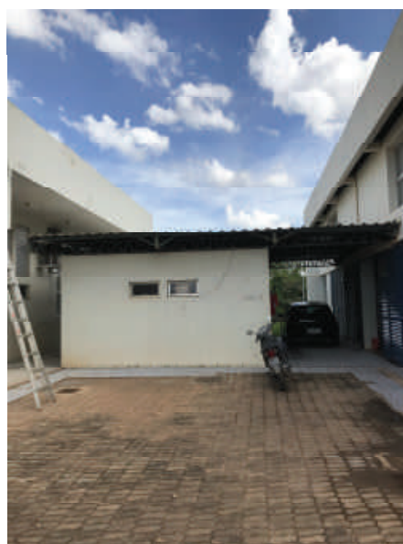
Foto 23 – Blocos I, II e III – Fachadas a receberem textura nas cores indicadas em projeto – Prancha 07/12
