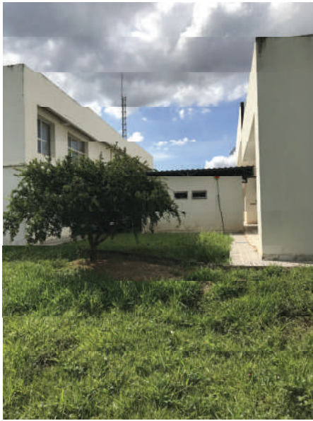
Foto 16 – Blocos I, II e III – Aplicação de texturas nas fachadas conforme cores especificadas em projeto.
