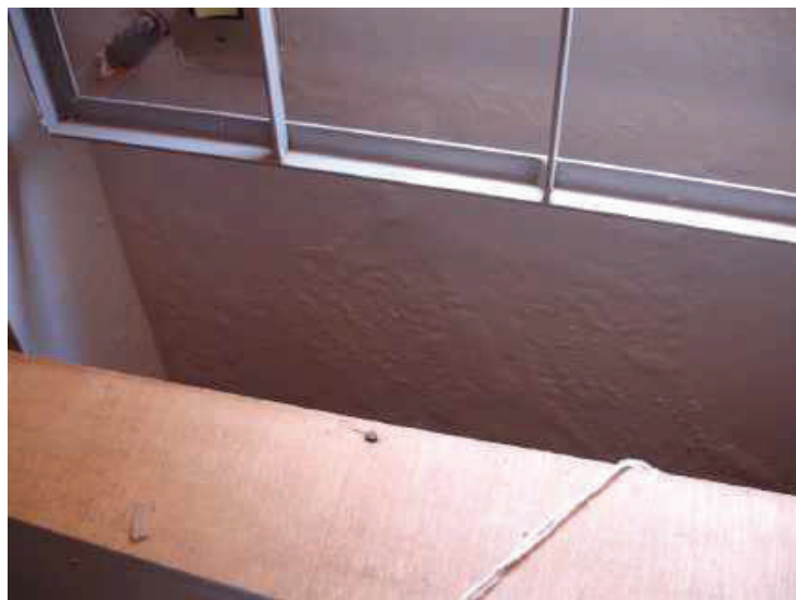
Foto 54 – Depósito de urnas – Remoção de reboco e tratamento da umidade ascendente. Pintura de paredes e das grades existente
