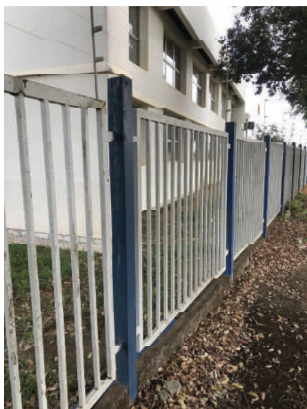
Foto 14 – Fachada posterior – Pintura do gradil na cor cinza platina, reboco e pintura nas muretas abaixo do gradil e texturização da fachada conforme cores especificadas em projeto
