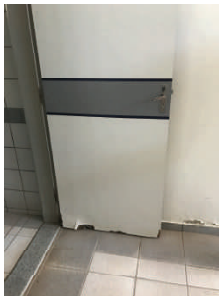
Foto 32 – Porta a ser removida, juntamente com portais, vão a ser aumentado e instalada nova porta
