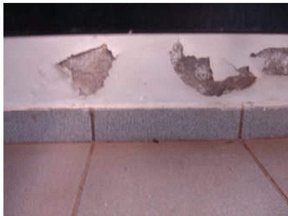
Foto 28 – Paredes com umidade ascendente a receber tratamento impermeabilizante com remoção de reboco até a altura de 70 cm e execução de novo revestimento
