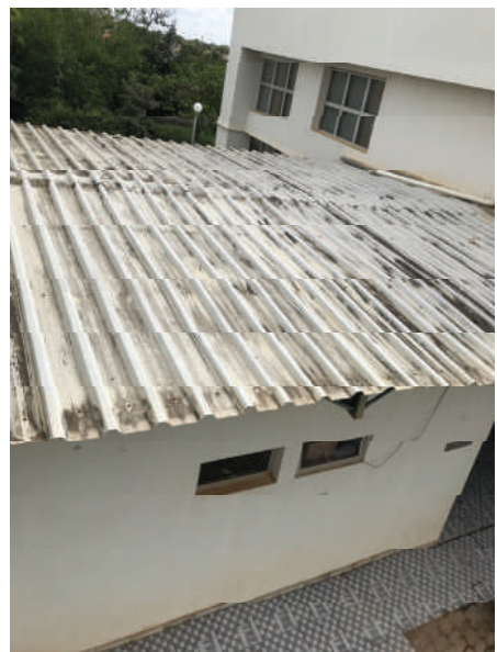
Foto 19 – Telhado do Bloco II – Telhas e estrutura sob telhado a serem lavadas com água e sabão neutro para posterior pintura sobre tratamento antiferrugem (estrutura metálica)
