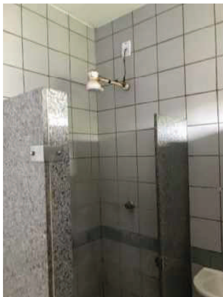
Foto 46 – Serviço bloco II – Demolição de pisos e revestimentos, divisórias, troca de louças (bacias sanitária, lavatório, chuveiro)
