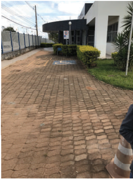
Foto 5 – Vista interna – Vaga reservada de veículos com pintura da sinalização a ser retocada
