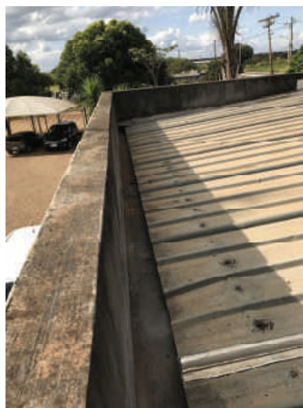
Foto 21 – Telhado bloco I – parte lateral - Instalação de chapim de concreto pré-moldado, substituição de telhado por telhas galvalume e substituição de rufos.
