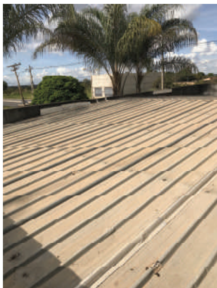
Foto 20 – Telhado bloco I – parte central – Instalação de chapim de concreto pré-moldado, substituição de telhado por telhas galvalume e substituição de rufos
