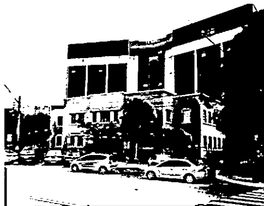
Imagem 2: Atual TRE, com volume anexo no fundo do bem tombado
