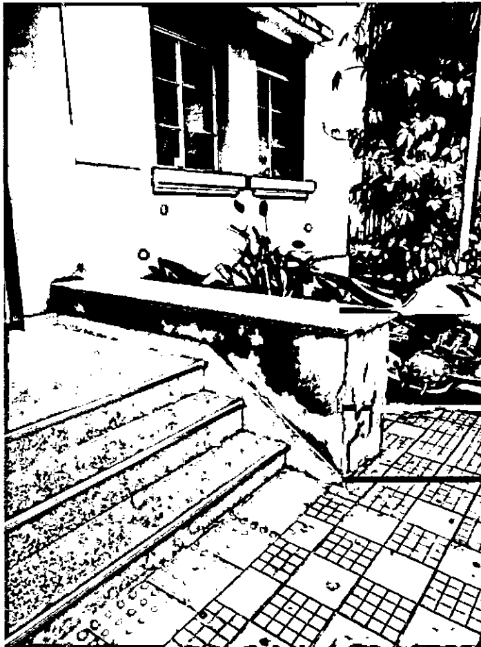
Imagem 03 - Indicação de perda do revestimento em granilha na escadaria de entrada do TRE/GO.
