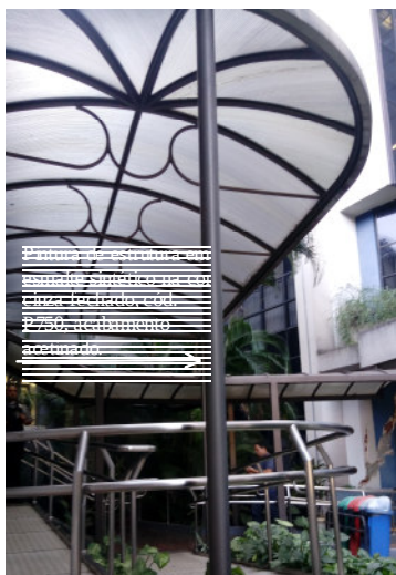
Foto 23 - Pintura da estrutura da cobertura de rampa e passarela
