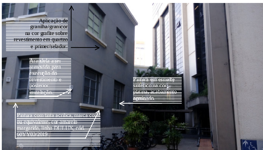
Foto 14 – Fachada posterior – Serviços a serem executados – Revestimentos e impermeabilizações
