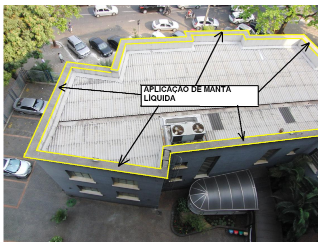
Foto 10 – Manta líquida no topo das platibandas
