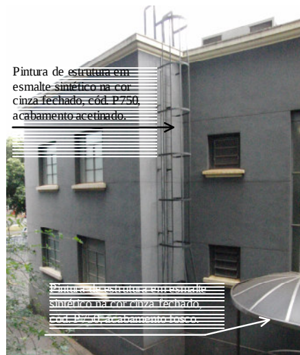
Foto 24 - Pintura da estrutura da cobertura de rampa e passarela
