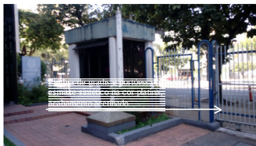
Foto 23 – Pintura de gradis
