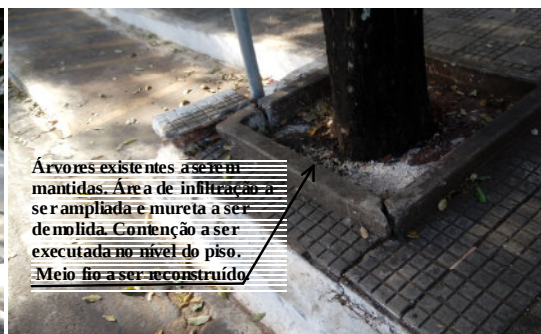
Foto 4 – Área de infiltração a ser ampliada
