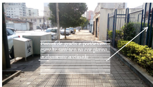
Foto 27 – Pintura de gradis
