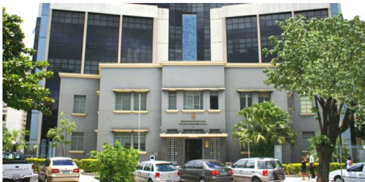
Foto 1 – Fachada prédio Sede Histórica e áreas externas
