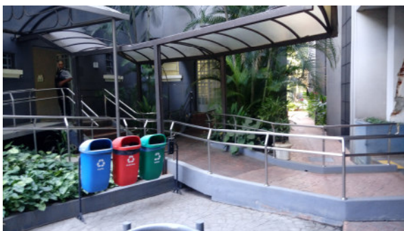
Foto 16 – Área de pintura de piso – Rampa, degraus/circulação
