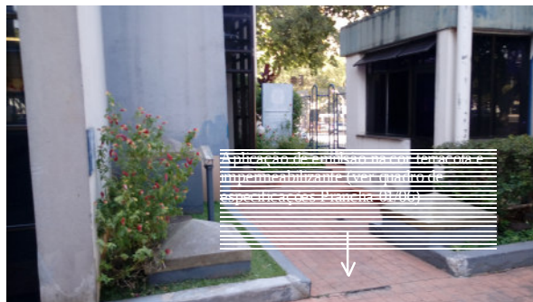
Foto 19 – Circulação entre edificações
