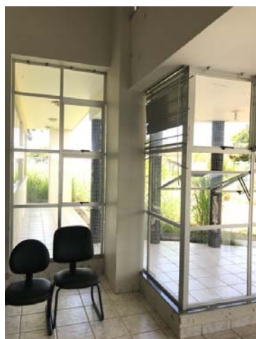
Foto 37 – Ajuste de esquadrias para execução de enchimento para compor o novo shaft de captação de águas pluviais, remoção de reboco na base da alvenaria para execução de impermeabilização.
