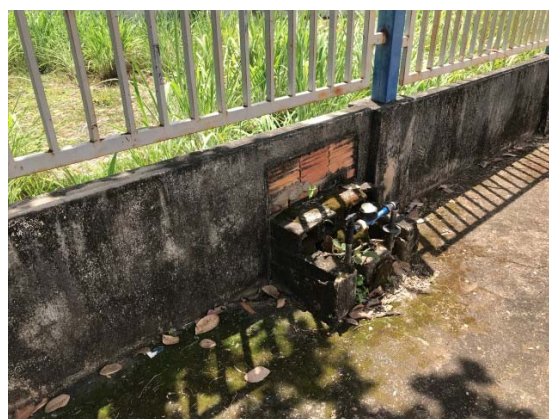
Foto 9 – Remoção e reinstalação de hidrômetro – Construção de mureta ao lado da existente
