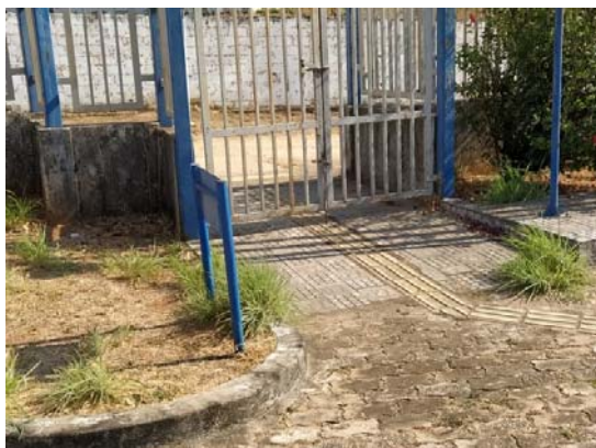
Foto 14 – Acesso de pedestres a ajustar. Execução de piso de concreto e piso tátil – Rota acessível
