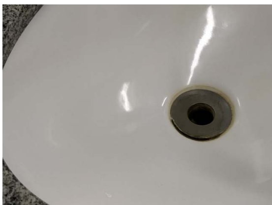
Foto 59 – Troca de válvulas dos lavatórios por peças metálicas, com acabamento cromado, no Bloco 2 (lavatórios de uso de servidores)
