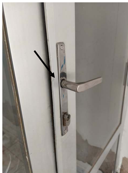
Foto 54 – Substituição de maçanetas nas portas de alumínio e alumínio e vidro existentes. Ajuste das portas de acesso principal, as quais estão prendendo na soleira.
