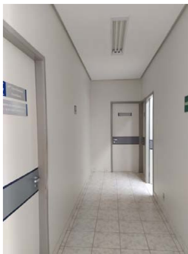
Foto 45 – Sinalização de circulação (incêndio, saídas de emergência) a serem removidas e reinstaladas após pintura de paredes. Maçanetas de portas existentes a serem substituídas.
