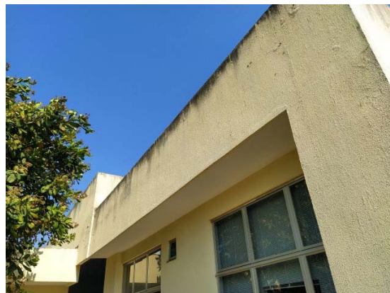
Foto 25 – Limpeza da parte superior e instalação de chapins nas platibandas.
