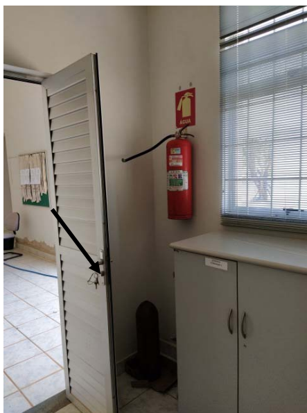
Foto 53 – Substituição de maçanetas nas portas de alumínio e alumínio e vidro existentes, por conjunto maçaneta/ fechadura Arouc ou equivalente, Linha Nova Perfil Metálico, cód. 160975-Z, acabamento inox
