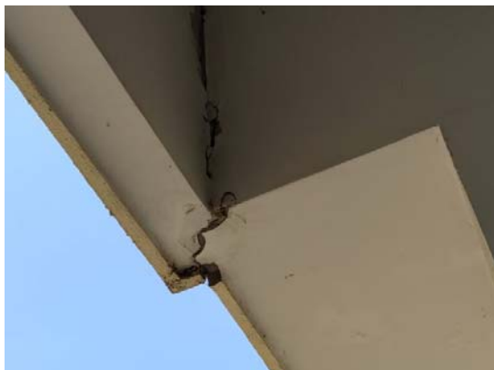
Foto 33 – Tratamento de trinca nos cantos laterais das platibandas por meio de grampeamento.
