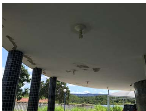
Foto 32 – Remoção de tinta com deslocamento, tratamento de ferrugem exposta com produto neutralizador de ferrugem, para posterior execução de revestimento – reboco, emassamento e pintura acrílicos, na cor branco neve.
