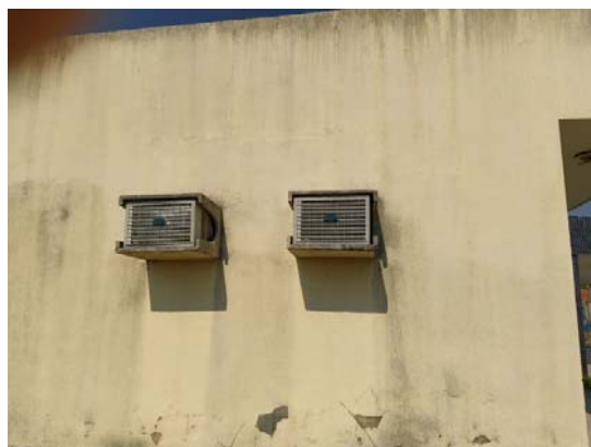
Foto 36 – Remoção de suporte de ar condicionado e vedação do vão, emassamento e pintura (face interna) ou aplicação de textura acrílica sobre fundo preparador (face externa)
