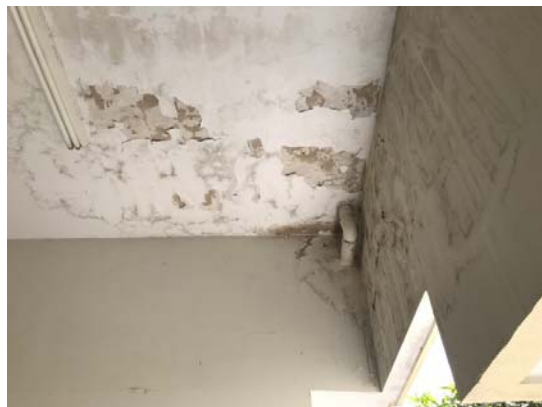
Foto 34 – Demolição de duto de captação de águas pluviais, execução de nova instalação conforme projeto hidrossanitário, remoção de pintura em estado de esfarelamento, remoção de reboco na lateral do duto, e recomposição dos revestimentos e acabamentos.
