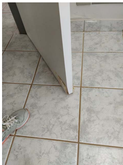
Foto 56 – Execução de reparo no laminado das bases das portas, onde houver descolamento.
