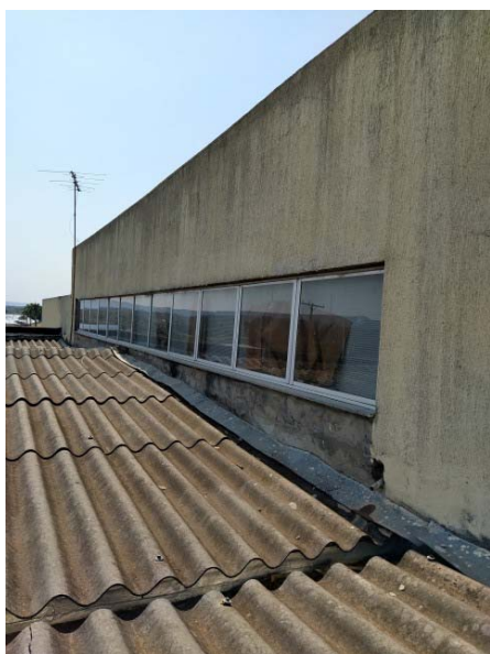
Foto 20 – Janela sobre marquise circular a ser demolida. Vão vedado com blocos cerâmicos e execução de novo telhado, conforme projeto de cobertura, ver prancha específica.
