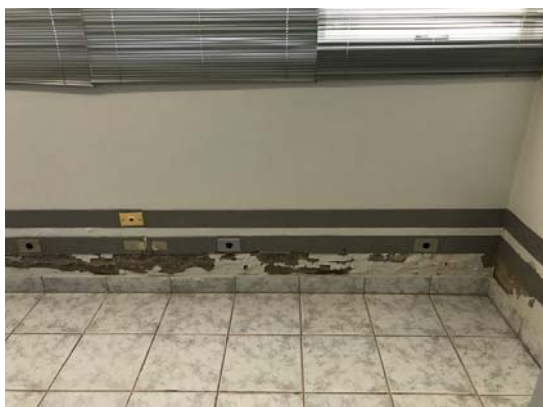
Foto 47 A – Eletrocalhas de parede a serem removidas, reboco demolido para execução de impermeabilização, rodapé removido para vedação de fresta da parede com o piso e posterior recomposição do revestimento.
