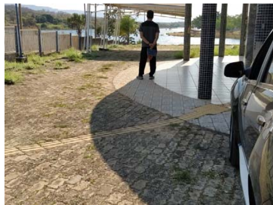
Foto 15 – Acesso de pedestres a ajustar. Execução de piso de concreto e piso tátil – Rota acessível
