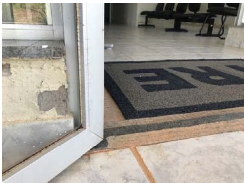
Foto 27 – Demolição de soleira e assentamento de nova peça em granito cinza andorinha, com acabamento levigado.
