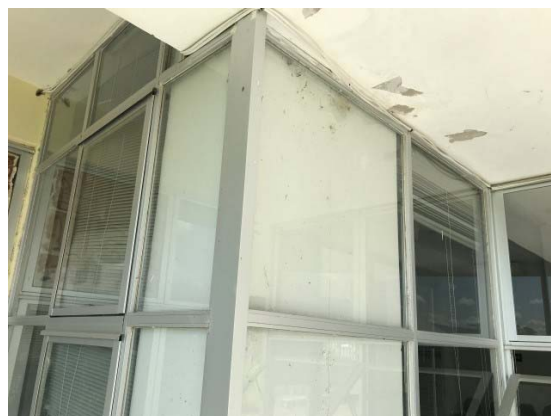
Foto 26 A – Demolição de parte das esquadrias de canto junto ao shaft de descida da caixa d'água. Execução de enchimento para ampliação do shaft, corte dos perfis de alumínio e complementação do vão com perfis de alumínio, conforme Detalhe na Prancha 07/11 do Projeto de Arquitetura
