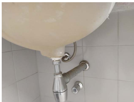
Foto 60 – Substituição de engates flexíveis, metálicos, com acabamento cromado. Sifões devem ser removidos, limpos, armazenados e reinstalados.
