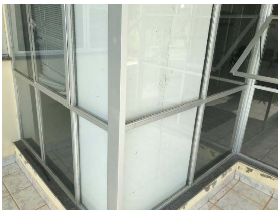
Foto 26 – Demolição de parte das esquadrias de canto junto ao shaft de descida da caixa d'água. Execução de enchimento para ampliação do shaft, corte dos perfis de alumínio e complementação do vão com perfis de alumínio, conforme Detalhe na Prancha 07/11 do Projeto de Arquitetura.
