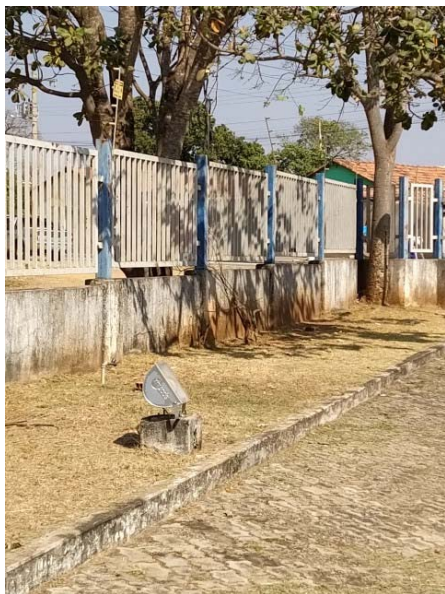
Foto 18 - Pintura interna das muretas e gradis – Textura acrílica com rolo para pintura média (alvenaria) e pintura em esmalte na cor platina sobre zarcão (gradis).
