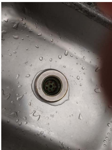
Foto 61 - Troca de válvula americana, por peça em aço inox, com tampa/cesto em inox.
