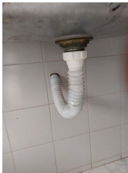
Foto 62 – Sifões deverão ser removidos, limpos e reinstalados. .
