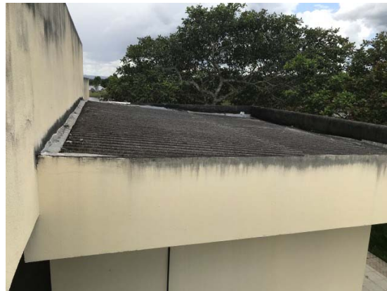
Foto 23 – Remoção de telhas existentes, execução de nova calha (parte em alvenaria) e instalação de novo telhamento em fibrocimento e=6mm
