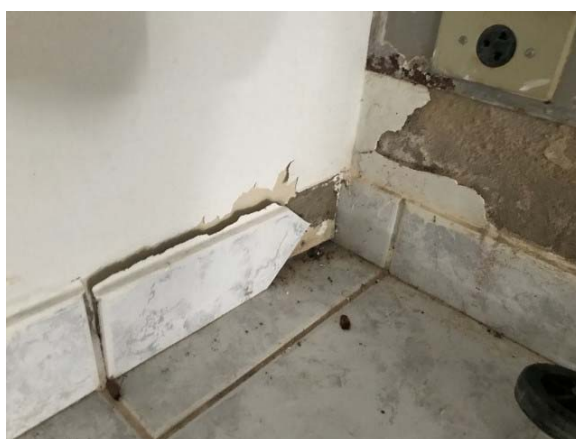
Foto 50 – Complementação de rodapé – Parede de gesso entre depósito de urnas e arquivo
