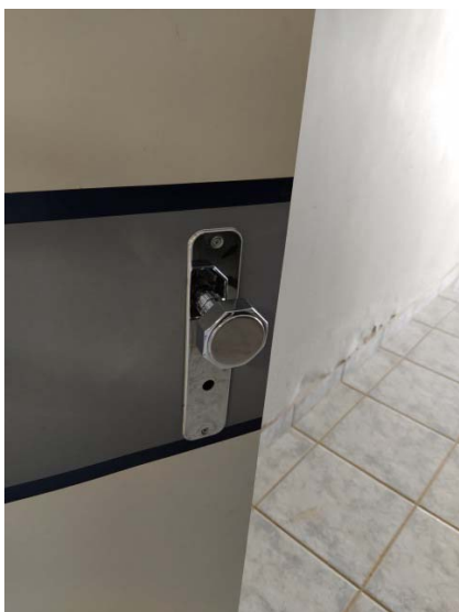
Foto 55 – Substituição de maçanetas das portas de madeira a serem mantidas, por peças da marca IMAB, Linha Duna (acionamento tipo alavanca) de 10 cm.
