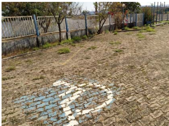
Foto 12 – Refazimento de sinalização horizontal para demarcação de vagas, Ver detalhes Proj. Arquit. Pr. 02/11
