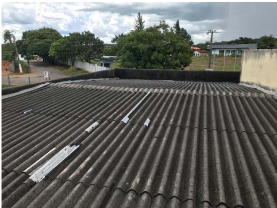
Foto 22 – Remoção de telhas existentes e execução de novo telhamento em fibrocimento, e = 6mm
