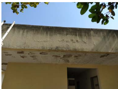
Foto 31 – Remoção de textura das platibandas, remoção de acabamento da face inferior das lajes, para posterior execução de emassamento e pintura acrílicos em laje e execução de textura acrílica e instalação de chapins de concreto, nas platibandas
