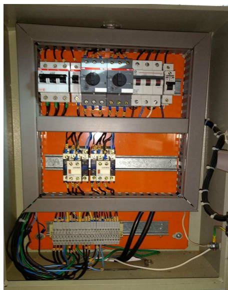
Figura 2 - Atual quadro QD-EX-01. Sobreposto na parede.
