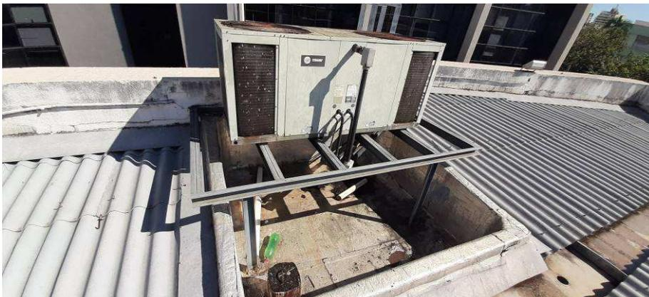
Esta Unidade Condensadora será retirada, mas a estrutura metálica de sua base de sustentação deverá ser reaproveitada para receber as duas novas unidades condensadoras (Ver Projeto).
