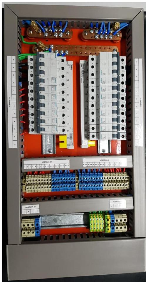
3.29. Para prover proteção contra contato direto, deverão ser instalados terminais apropriados nos dentes dos pentes de alimentação que não forem utilizados. Jamais será permitido que os pentes sejam cortados ou outra solução inapropriada;
