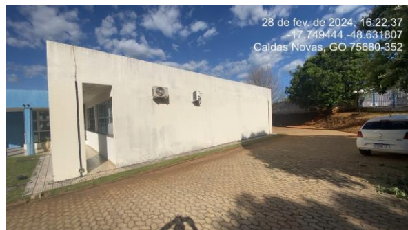
Foto 16: Refazer pintura externa, e assentar chapim na platibanda.
