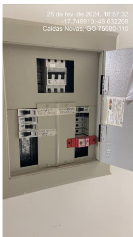
Foto 61: Adicionar IDR no quadro distribuição.
