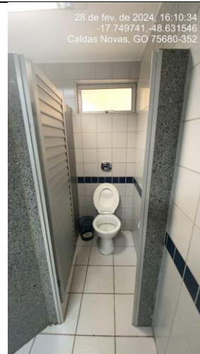
Foto 46: Adequar novo layout para acessibilidade.
