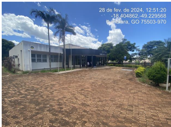
Foto 13: Aplicar ácido para fazer a limpeza no pavimento intertravado, pintura da fachada do edifício e realizar a instalação do Chapim na platibanda.
