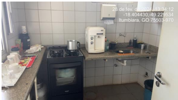
Foto 88: Retirar gás da copa e executar central de gás.
