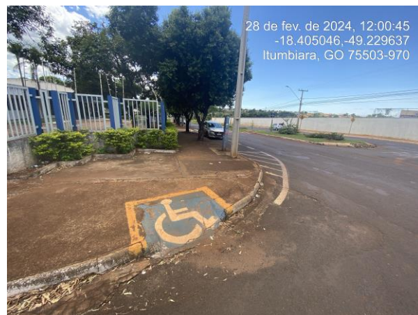
Foto 08: Adequar rampa de acessibilidade A Rua João Batista da Silva Mariano c/ Av. João Paulo I
