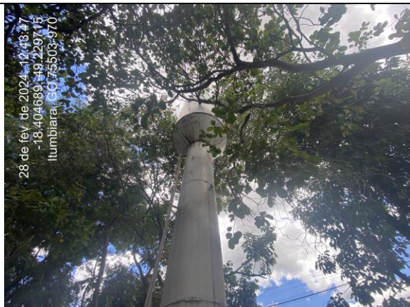
Foto 21: Fazer podas de árvores, próximo ao reservatório.
