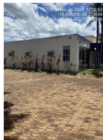
Foto 39: Remoção de suporte de ar-condicionado e vedação do vão, emassamento e pintura (face interna) ou aplicação de textura acrílica sobre fundo preparador (face externa).
