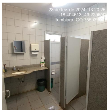
Foto 103: Instalar espelho sobre bancada, trocar substituir portas.
