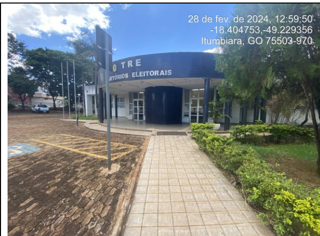
Foto 24: Demolir e reconstruir calçada da entrada e instalar piso tátil.
