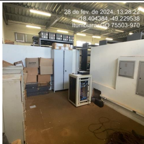
Foto 110: Fazer cobertura de gesso, para isolar a central equipamento e climatizar
