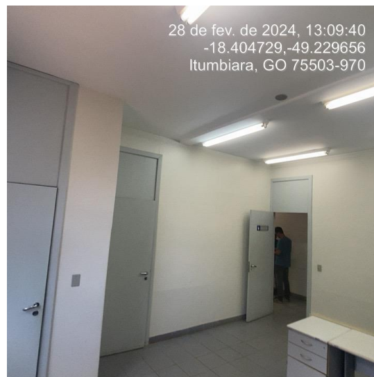
Foto 62: portas se encontra estufadas e empenadas. Trocar portas
