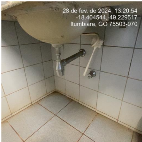
Foto 100: Trocar revestimento piso, parede, sifão e válvula do lavatório.
