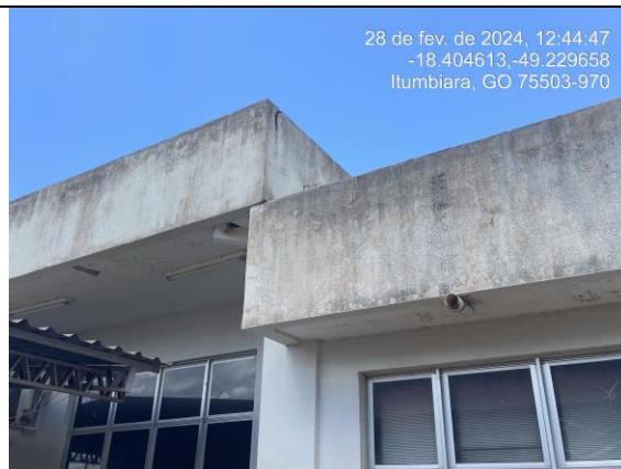
Foto 33: Fazer tratamento de trinta, e instalar chapim.
