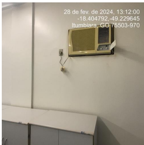
Foto 56: Fazer fechamento do shaft do ar - condicionando em alvenaria.
