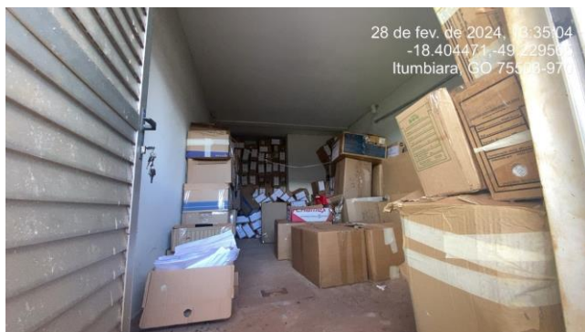
Foto 104: Executar pintura no piso e paredes.
