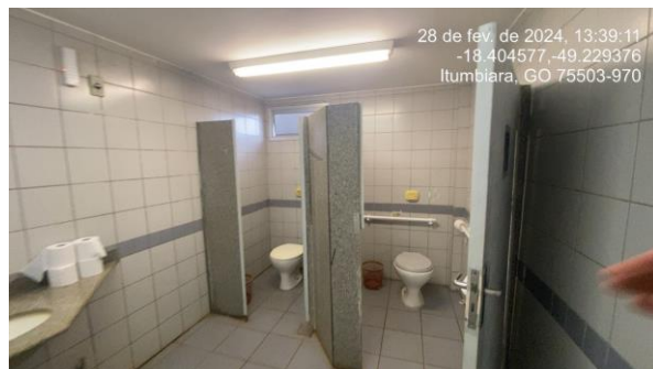
Foto 50: Substituir barras de apoio de pvc para inox.
