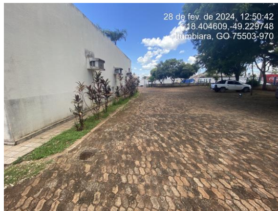
Foto 14: Aplicar ácido para fazer a limpeza do piso intertravado.
