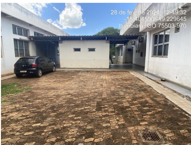
Foto 15: Demolir calçada de proteção e reconstruir. limpeza das grelhas de água pluvial. Refazer a sinalização horizontal para demarcação de vagas.
