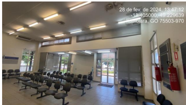
Foto 41: Recepção/atendimento – Fazer fechamento das janelas em alvenaria sobre a marquise da entrada.
