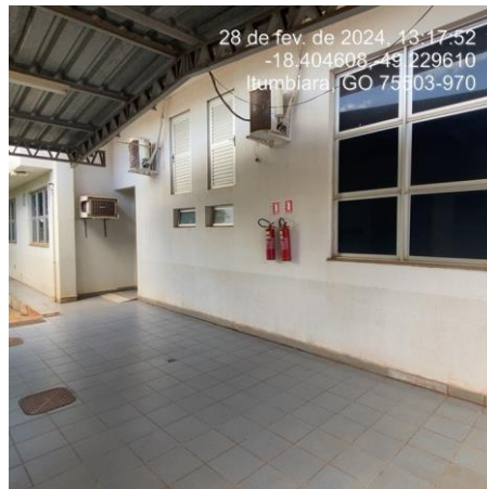
Foto 105: Execução de plataforma/mezanino de acesso para arquivos no piso superior.
