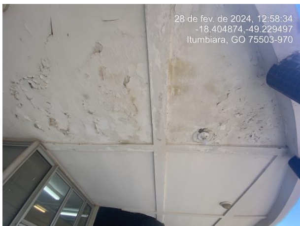
Foto 30: Escarificar teto, remover impureza e oxidações da ferragem, e reparar com graute.
