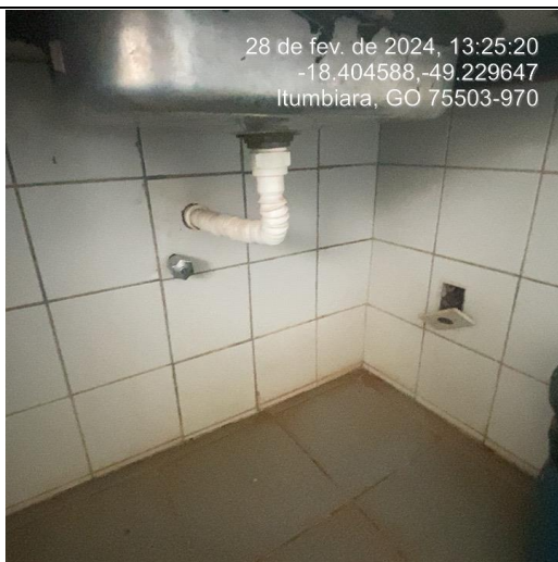
Foto 90: Trocar sifão, tomadas, interruptores e acabamento de registros.
