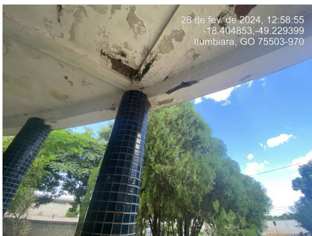
Foto 28: Escarificar teto, remover impureza e oxidações da ferragem, e reparar com graute.
