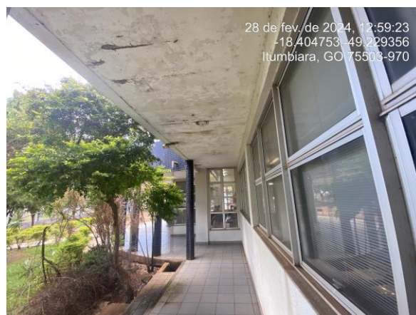
Foto 31: Escarificar teto, remover impureza e oxidações da ferragem, e reparar com graute.
