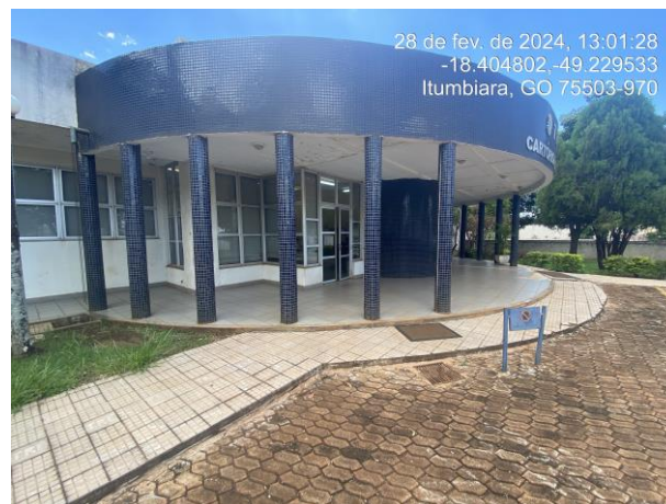
Foto 27: Demolir e reconstruir calçada da entrada e instalar piso tátil.
