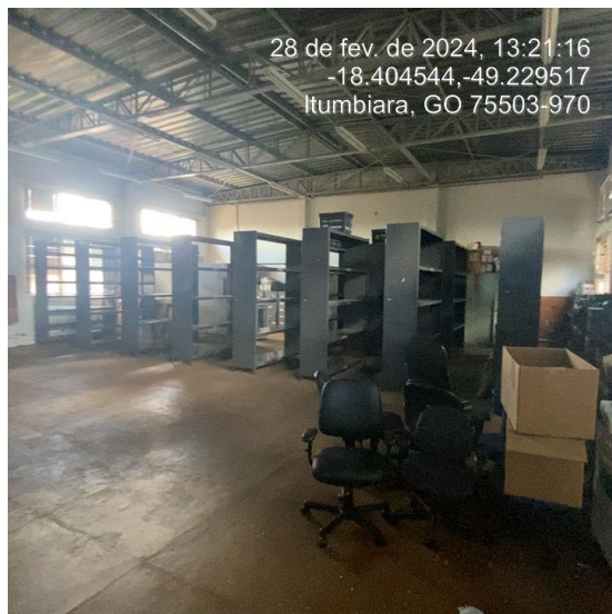
Foto 116: Executar pintura no piso.
