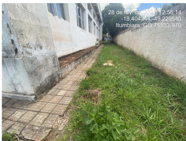
Foto 34: Demolir e construir calçada de proteção, remover reboco e aplicar novo revestimento com cal-hidratado.
