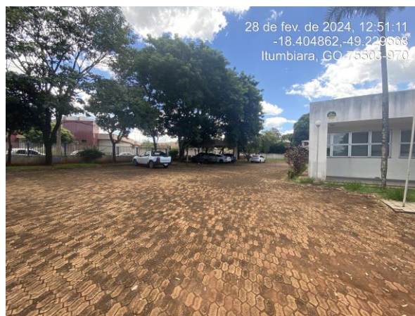
Foto 16: Aplicar ácido para fazer a limpeza do piso intertravado.
