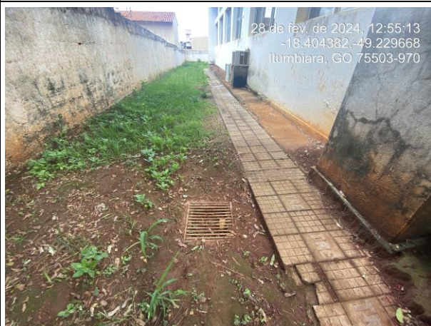
Foto 38: Levantar o ponto das grelhas e fazer limpeza.
