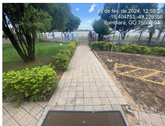
Foto 25: Demolir e reconstruir calçada da entrada e instalar piso tátil.
