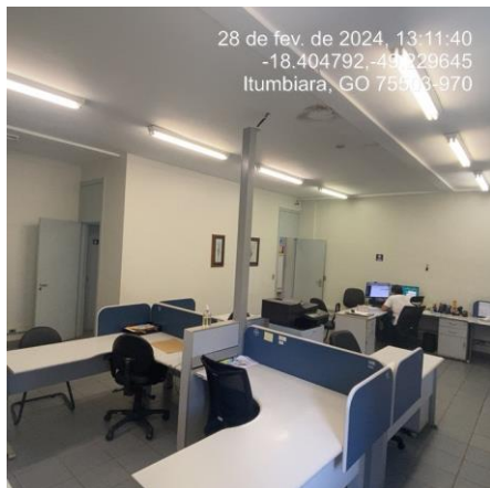
Foto 54: Remoção de coluna central – instalações elétricas – para execução de novo layout. Placa cerâmica, na base da coluna, deverá ser substituída por peça cerâmica disponível no Cartório.
