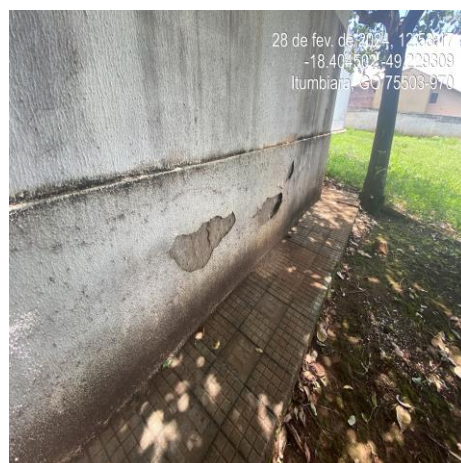
Foto 35: Remover reboco e aplicar novo revestimento com cal-hidratado.
