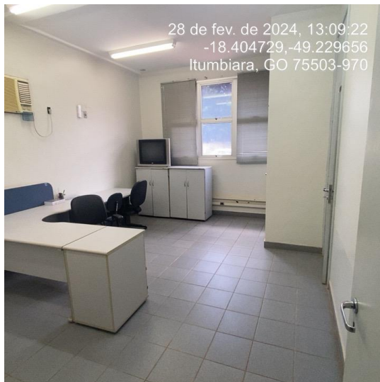
Foto 61: Fazer fechamento do shaft do ar-condicionado.
