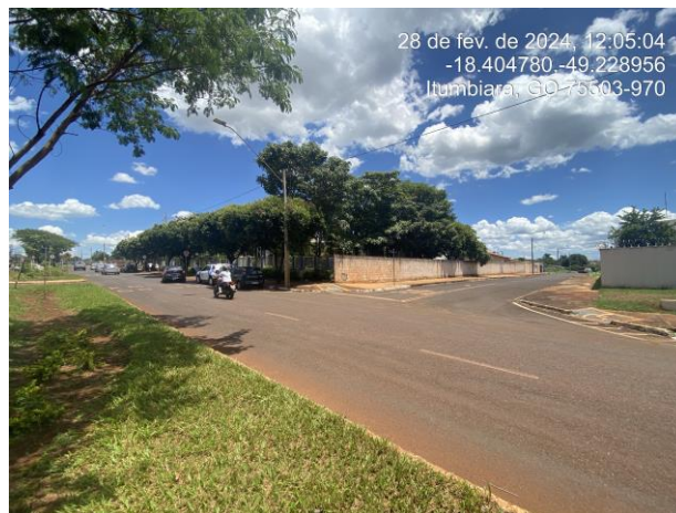
Foto 04: Fachada Lateral Esquerda- Av. João Paulo I c/ rua Gercino Flausino Fidelis.
