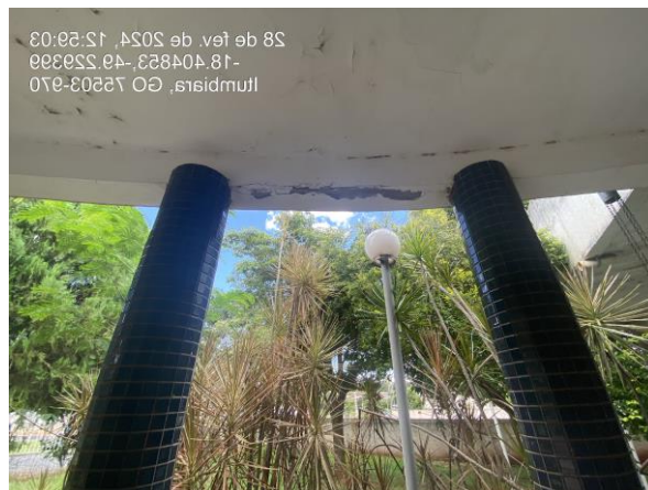
Foto 29: Escarificar teto, remover impureza e oxidações da ferragem, e reparar com graute.
