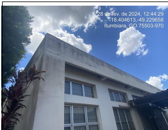
Foto 32: Fazer tratamento de trinta e instalar chapim.
