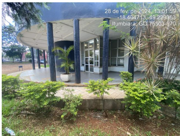
Foto 26: Demolir e reconstruir calçada da entrada e instalar piso tátil.
