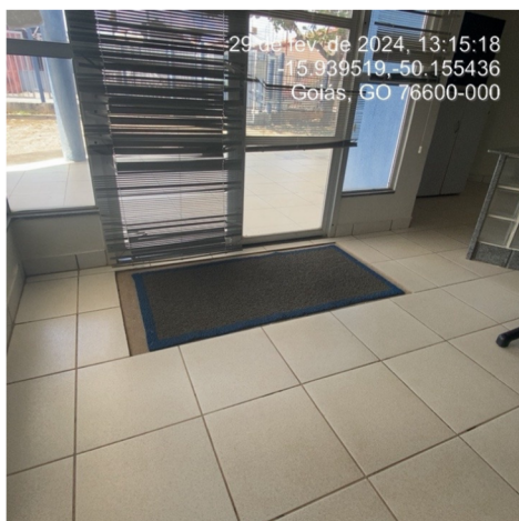
Foto 55: Remover rebaixo do piso.
