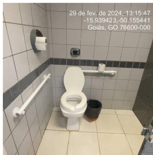
Foto 67: Substituir para de apoio de PVC por barras de INOX
