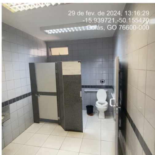
Foto 70: Substituir para de apoio de PVC por barras de INOX
