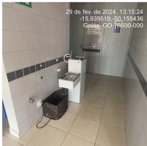
Foto 54: Remover portas dos banheiros, para novo layout.
