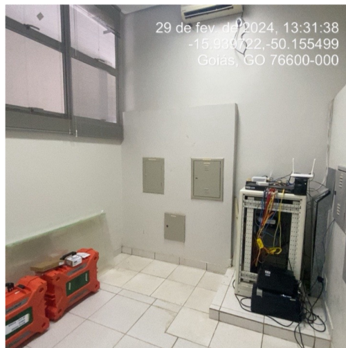
Foto 48: Infiltrações no teto.
