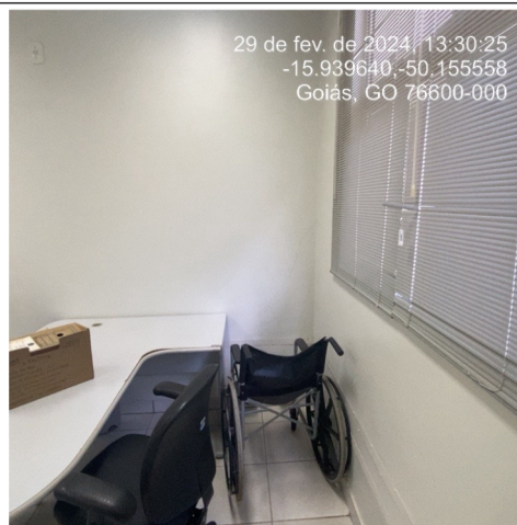
Foto 34: Infiltrações nas paredes por capilaridade.
