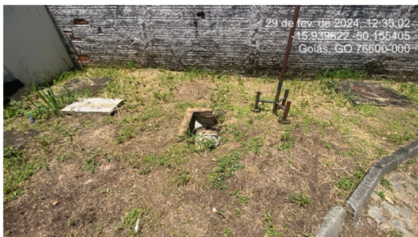
Foto 25: Repara caixa de inspeção, próximo ao padrão de energia.
