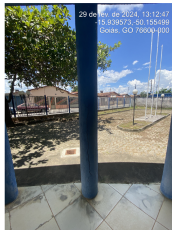
Foto 18: Fazer reparação estrutura no pilar.
