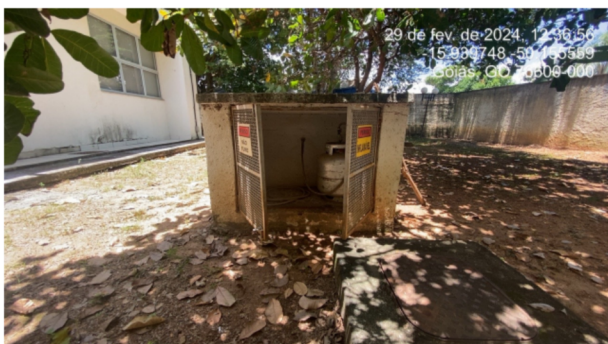
Foto 27: Refazer pintura na central de gás
