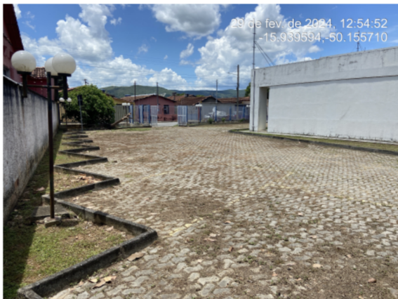
Foto 05: A Fazer demarcação das vagas de garagem e sinalizar vaga de PNE
