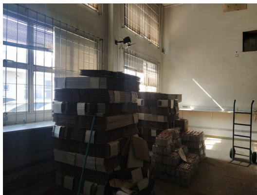
Foto 50 - Grades existentes também receberão nova pintura após revisão dos pontos de oxidação e de fixação. Bancada de urnas existente deverá ser removida e instalado novo mobiliário
