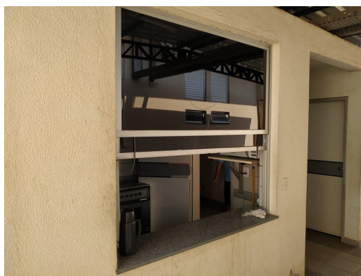
Foto 36 – Esquadria de alumínio e vidro a ser substituída por porta de enrolar
