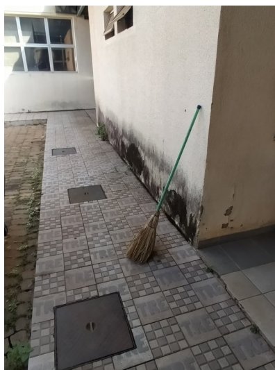
Foto 40 – Manchas de umidade na base das paredes a serem tratadas. Construção de casa de gás e deslocamento da caixa de gordura. Instalação de grades nos vãos das esquadrias – ver detalhes na prancha 07/18 de arquitetura e projeto específico de impermeabilização
