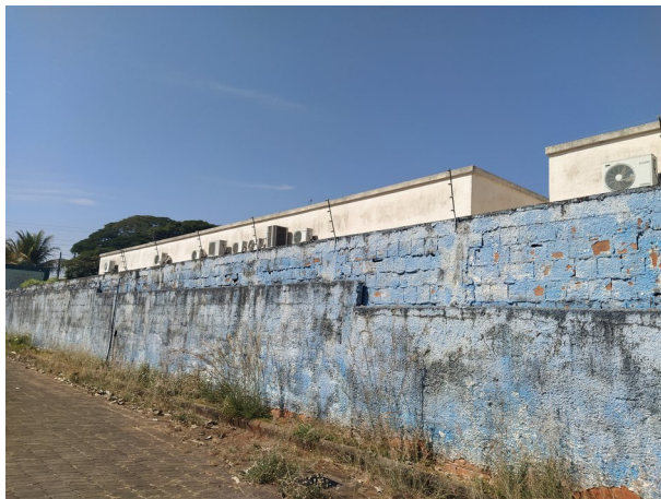
Foto 52 – Muro de divisa a receber novos chapisco e reboco, selador e textura acrílica. O topo do muro, no encontro com o do vizinho, deverá receber tratamento para vedação de fresta entre os mesmos – Ver Figura 33 no memorial e Detalhe 01- Prancha 03/18
