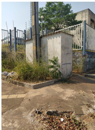
Foto 9 – Reconstrução de passeio, telhamento de abrigo do padrão e aplicação de textura acrílica
