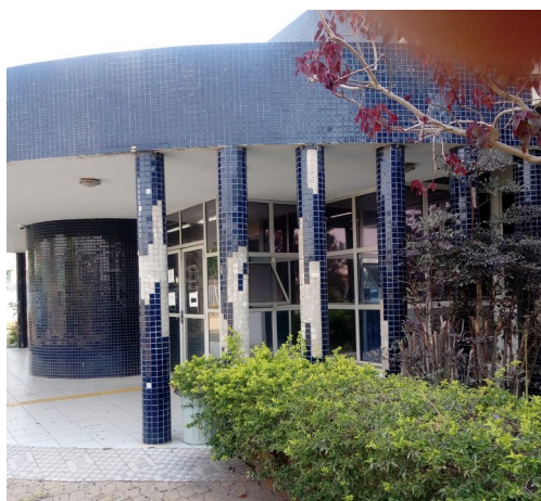
Foto 16 – Complementação de revestimento, acréscimo de platibanda, reconstrução de calçada de proteção (rampada) com 1,00m em ladrilho, pranchas 07/18 e 09/18.
