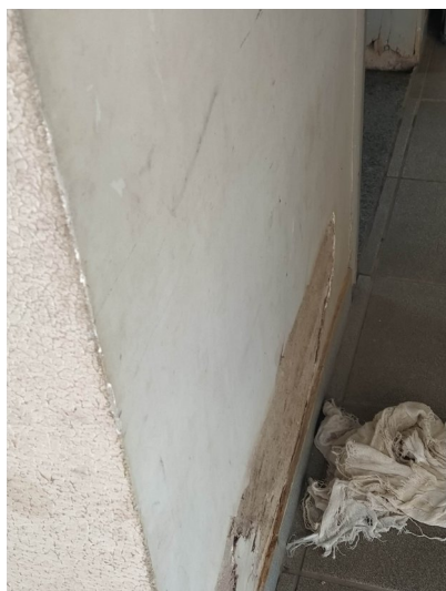
Foto 39 – Tratamento de umidade ascendente na base das paredes – Imagem da área de circulação no Bloco 2
