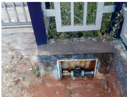
Foto 13 – Troca do hidrômetro
