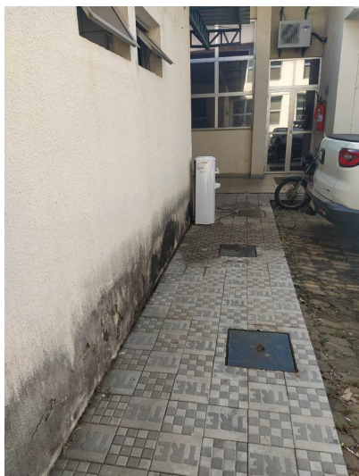
Foto 37 – Manchas de umidade na base das paredes a serem tratadas. Construção de casa de gás e deslocamento da caixa de gordura. – ver detalhes na prancha 07/18 de arquitetura e projeto específico de impermeabilização
