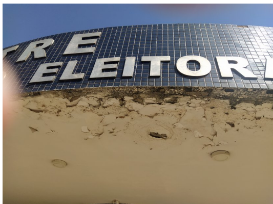
Foto 18 – Tratamento da pontos de unidade em lajes de forro
