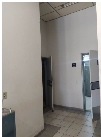
Foto 26 – Entrada sanitários de uso público coletivo. Substituição de revestimentos – pintura, forro, piso, aumento do vão das portas e troca de esquadrias de madeira
