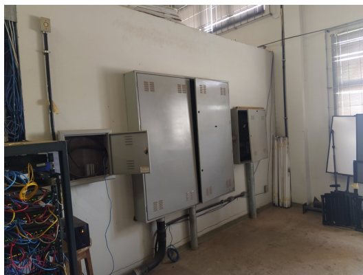
Foto 52 – Sala técnica deverá nova pintura de piso e parede, novo rodapé e guarda-corpo no encontro com das paredes com piso do mezanino. Quadros elétricos serão mantidos.
