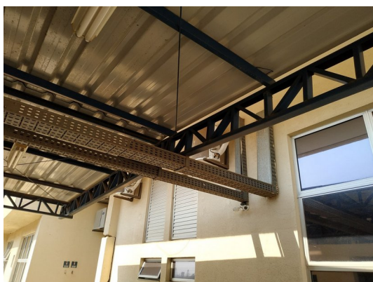
Foto 35 – Estrutura metálica existente a receber nova pintura – ver especificações no quadro de especificações gerais – prancha 07/18. Uma das eletrocalhas deverá ser desativada (cabearamento)
