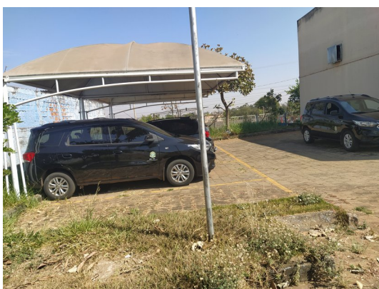
Foto 45 – Estrutura de cobertura de vagas de estacionamento – Execução de nova pintura em esmalte sintético da estrutura metálica e troca da lona de cobertura por tela impermeabilizada – Ver especificações na Prancha 03/18 e memorial descritivo
