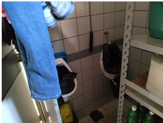
Foto 42 – Sanitário masculino a ser convertido em área de serviço. Troca de revestimentos, execução de novos pontos de água e esgoto, ligação dos pontos com redes de distribuição, troca de portas, instalação de bancadas e de armários.
