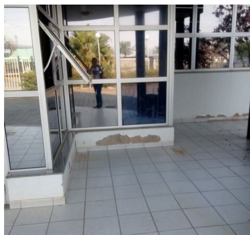
Foto 17 – Tratamento da base das paredes – ver projeto de impermeabilização
