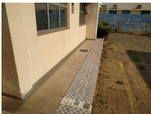
Foto 14 – Demolição de piso cerâmico (projeção da platibanda do bloco lateral) e reconstrução em ladrilho hidráulico
