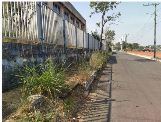
Foto 7 – Passeio na divisa posterior a demolir e reconstruir, com ajuste de nível.
