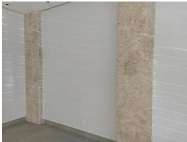
Foto 2 - Revestimento em mármore a ser demolido
