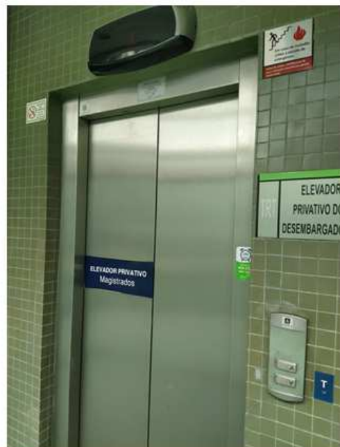
Foto 12 – Revestimento da caixa do elevador até as alturas indicadas em projeto. Remoção de botoeiras, display de indicação de pavimentos e placas a serem removidas e reinstaladas após execução do revestimento.
