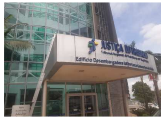
Foto 14 – Marquise a receber novo revestimento em ACM, novos letreiros em chapa galvanizada e pintura automotiva, brasão em aço inox, forro de gesso acartonado – placa verde, novas luminárias – Ver especificações Prancha 07/07
