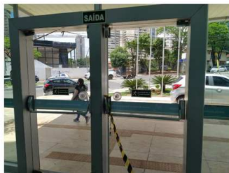
Foto 19 – Pórtico existente – Revestimento a ser removido e descartado para posterior instalação de novo revestimento em ACM. As portas deverão ser desinstaladas e reinstaladas após a execução do novo revestimento.
