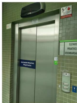
Foto 12 – Revestimento da caixa do elevador até as alturas indicadas em projeto. Remoção de botoeiras, display de indicação de pavimentos e placas a serem removidas e reinstaladas após execução do revestimento.
