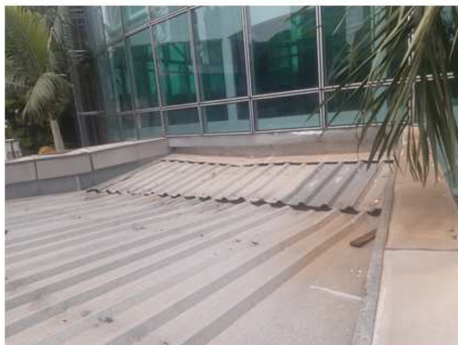
Foto 15 – Revestimento existente (marquise) a ser substituído por novo revestimento em ACM preto fosco. Rufos, telhas, calhas e tubulações a serem mantidas. Encontro entre esquadria e revestimento em ACM a ser vedado com silicone.
