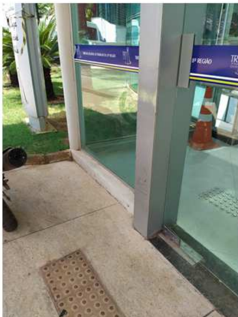
Foto 17 – Pórtico existente com revestimento a ser removido para instalação de novo revestimento. Adesivos existentes a serem removidos, portas a serem desinstaladas para execução do novo revestimento e reinstaladas.
