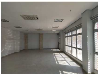
Foto 3- Pintura geral, com tinta acrílica, de parede e teto, nas cores especificadas em projeto.
