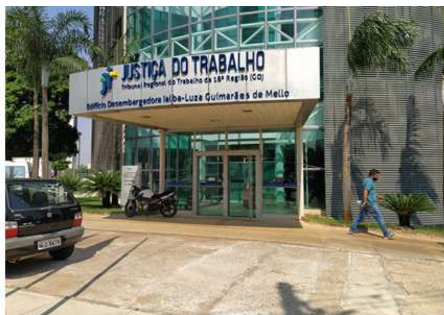
Foto 13 –Marquise – Letreiro, revestimento, forro em PVC e luminárias existentes a remover e executar novos revestimentos e acabamentos
