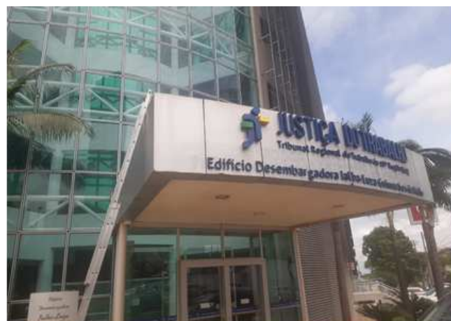
Foto 14 – Marquise a receber novo revestimento em ACM, novos letreiros em chapa galvanizada e pintura automotiva, brasão em aço inox, forro de gesso acartonado – placa verde, novas luminárias – Ver especificações Prancha 07/07
