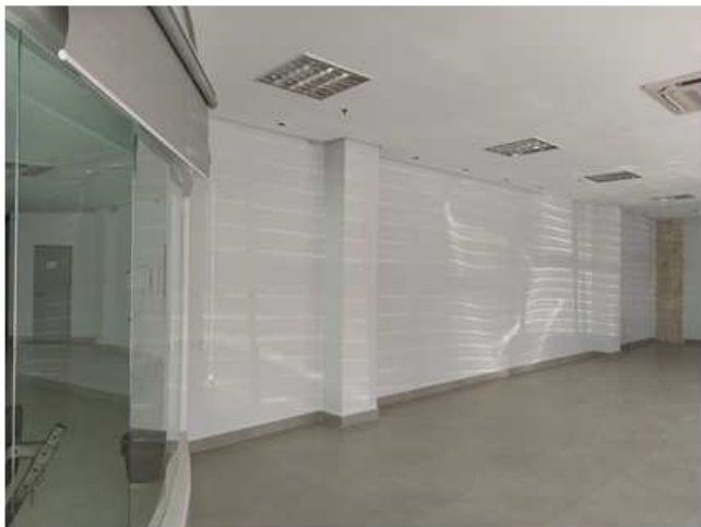
Foto 1 – Parede a receber painel, revestimento cimentício e rodapé em granito.
