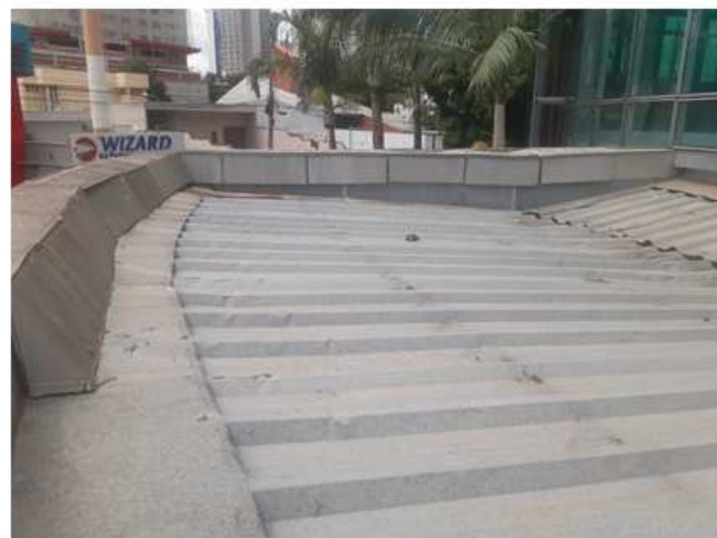
Foto 16 – Telhado (telhas e acessórios) existente a ser mantido. Revestimento em ACM a ser substituído. Novas placas de ACM devem recobrir rufo existente.
