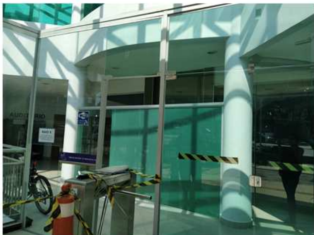
Foto 5 – Remoção de divisória de vidro e alumínio
