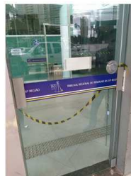
Foto 20 – Portas com trava interna (rota de fuga) a serem removidas e reinstaladas após a execução de novo revestimento do pórtico. Adesivo existente (azul) a ser removido.
