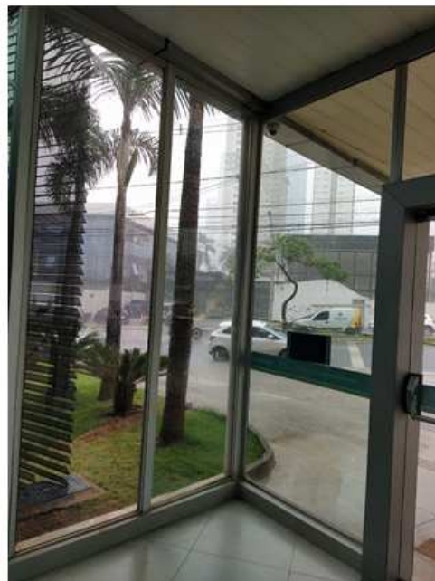
Foto 18 – Vista marquise área interna. Forro a ser reinstalado em gesso acartonado – placa verde – e execução de pintura com tinta acrílica. Luminárias a serem reinstaladas, conforme detalhes – Prancha 07/07
