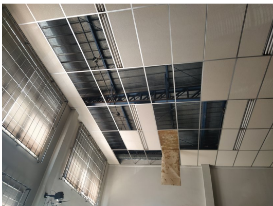
Foto 49 – Forro de fibra mineral a ser demolido descartado e estrutura metálica ficará aparente, coberta com telhas termoacústicas. Estrutura do telhado deverá receber nova pintura.
