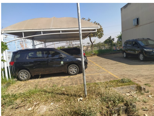
Foto 45 – Estrutura de cobertura de vagas de estacionamento – Execução de nova pintura em esmalte sintético da estrutura metálica e troca da lona de cobertura por tela impermeabilizada – Ver especificações na Prancha 03/18 e memorial descritivo
