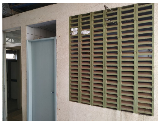
Foto 44 – Atual espaço da área de serviço a ser transformado em sanitário masculino. Vedação de vão de cobogós e de porta atuais. Abertura do vão da porta na parede voltada para circulação.
