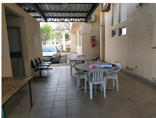
Foto 33 – Pátio de serviços – Tratamento de pontos de umidade, troca de revestimentos, execução de nova textura, pintura de estrutura metálica – Ver detalhes nas Pranchas 07, 09 e 17/18
