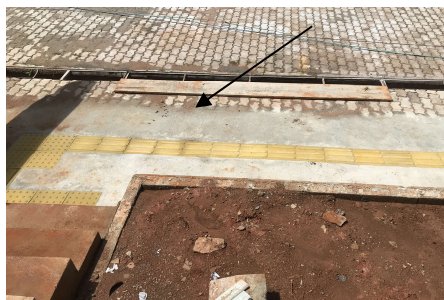
Figura 37 - Tipo de finalização entre concreto e bloco intertravado NÃO será permitida
