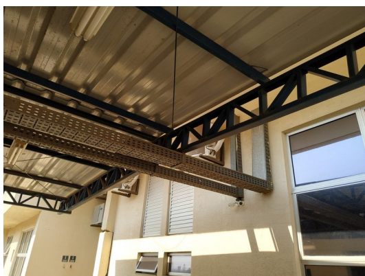
Foto 35 – Estrutura metálica existente a receber nova pintura – ver especificações no quadro de especificações gerais – prancha 07/18. Uma das eletrocalhas deverá ser desativada (cabecamento)
